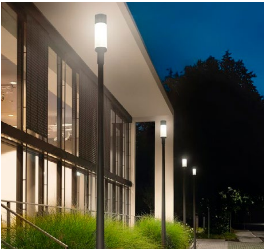
BEGA Außenbeleuchtung im Deutsche Lichtmiete® Mietmodell. Foto: © BEGA
